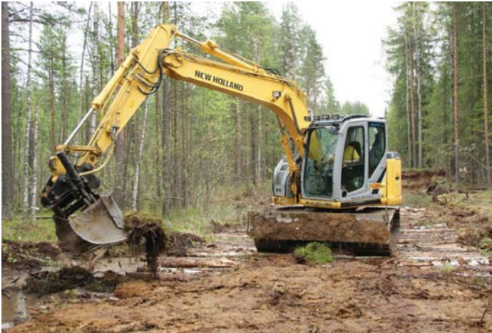
Рис. 2.6. Возведение насыпи на болоте без выторфовывания
