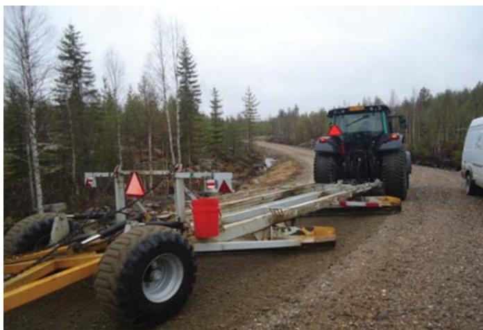
Рис. 3.11. Профилирование покрытия лесной дороги
