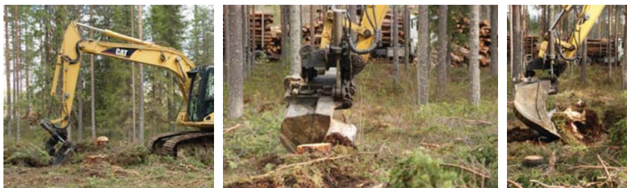
Рис. 2.2. Корчевка пней ковшем экскаватора
