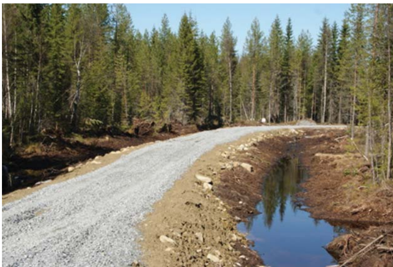
Рис. 2.7. Нижний слой основания дорожной одежды из щебеночной смеси
