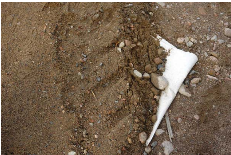
Рис. 1.11. Геотекстиль в конструкции дорожной одежды
