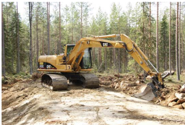
Рис. 2.5. Возведение насыпи одноковшовым экскаватором с планировочным ковшом
