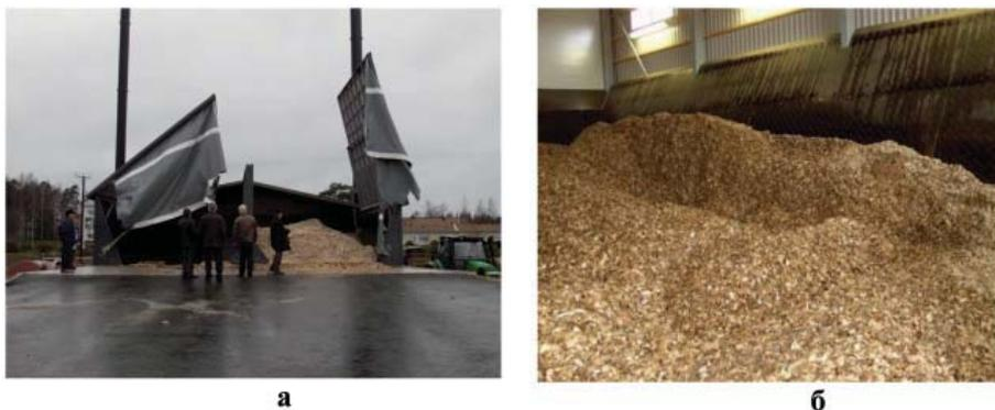
**Рис. 3.4.** Оборудование топливного склада, Финляндия: а — основной автоматический склад котельной с открывающейся крышей, б — основной автоматический склад топлива со штанговым толкателем «подвижной пол»
