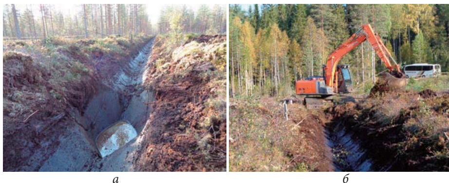
Рис. 2.3 Гидролесомелиорация: а — лесомелиоративная канава (фото А. Н. Пеккоев); б — строительство мелиоративной сети (фото А. Н. Пеккоева) [46]
