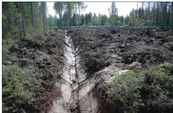
Рис. 6. С угнетёнными водами площади возобновления вода отводится по каналу, отрытому экскаватором. Фото: Маркку Туртиайнен
