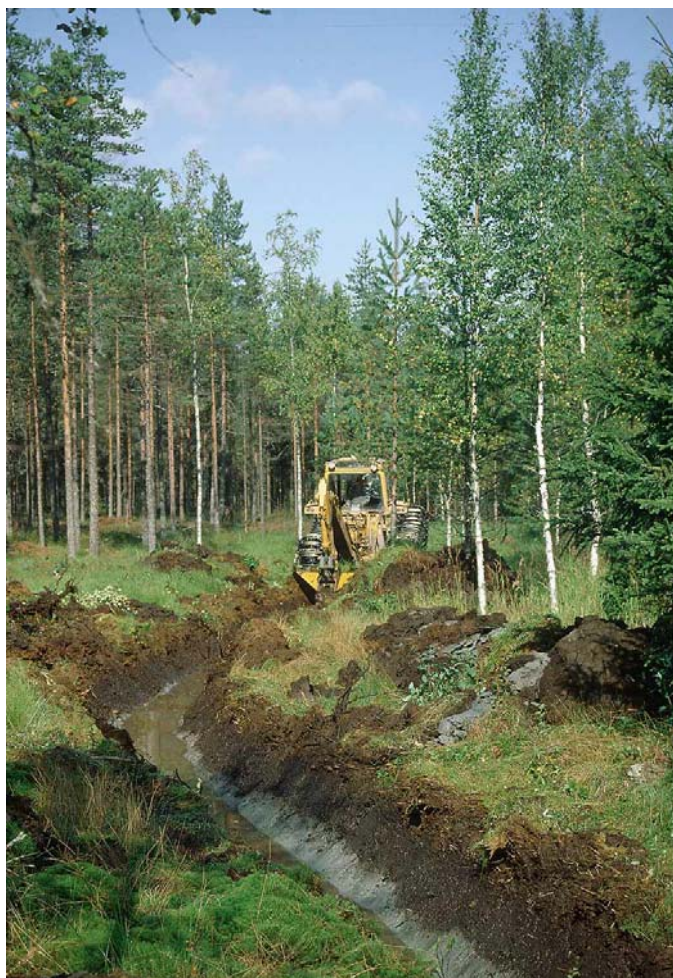
Фото 6. Реконструкцию осушения проводят для улучшения водного режима на перспективных объектах со старой осушительной сетью. Естественные болота не осушают.
